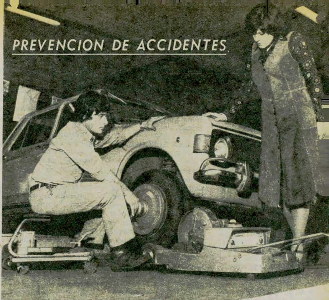
El balanceo estático y dinámico de las ruedas debe realizarse a intervalos regulares.
