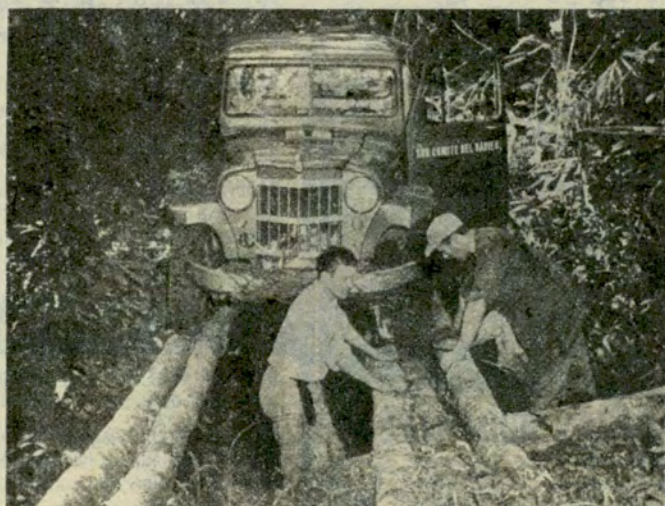
En algunos sectores de selva fue necesario utilizar puentecillos construidos in situ por las propias brigadas exploradoras. De todos modos, se demostró la viabilidad de la carretera en esa región, con la técnica actual.
